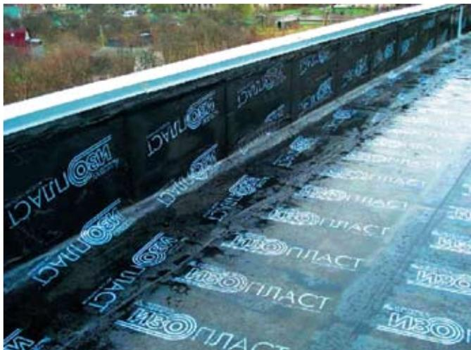
«Изопласт», «Изоэласт», «Кинепласт» выпускаются на полиэфирных и стекловолокнистых основах для верхнего и нижнего слоев кровельного пирога и гидроизоляции строительных конструкций.
