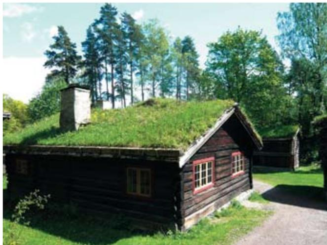
гидроизоляции для дома. Интенсивные кровли характеризуются большей толщиной субстрата, большим весом, значительными капитальными затратами, высокими требованиями к обслуживанию. Субстрат интенсивных кровель организуется на базе грунта глубиной 20–60 см, с весом в насыщенном состоянии от 250 до 950 кг/м<sup>2</sup>. Для создания надежной кровли нужны профессиональные консультации конструкторов и ландшафтных дизайнеров. Работы должен проводить только опытный кровельщик.
