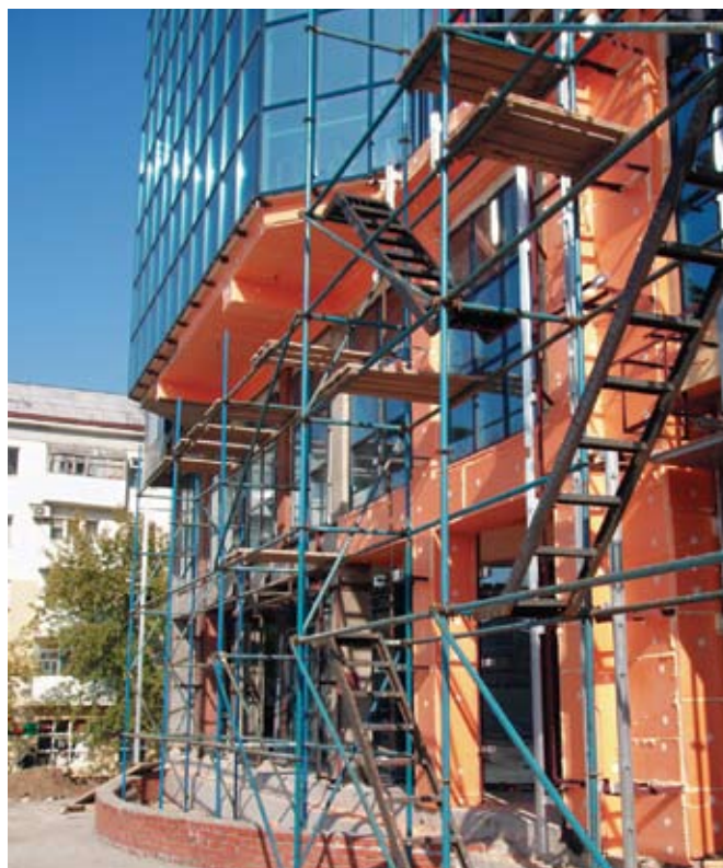
Пример применения экструдированного пенополистирола ПЕНОПЛЭКС на фасаде многоквартирного дома
