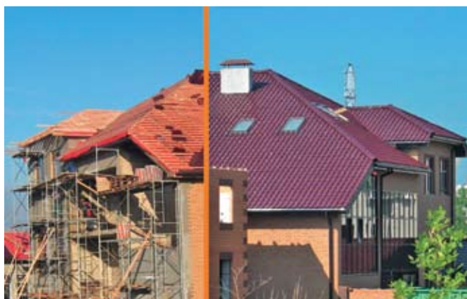
Утепление скатной кровли минераловатными плитами IZOVOL
