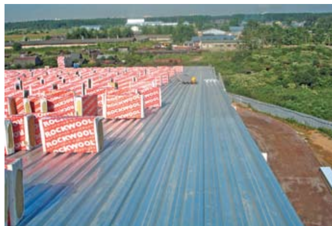
Утепление кровли плитами из каменной ваты ROCKWOOL защитит здание от теплопотерь
