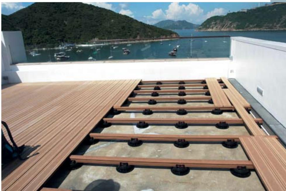
же особенность позволяет свободно циркулировать воздух под поверхностью покрытия, что способствует высыханию поверхности гидроизоляционного слоя. Свободное пространство между гидроизоляцией и террасными плитами дает возможность разместить все необходимые коммуникации, декоративную подсветку, а свободное проветривание исключает условия для развития вредной микрофлоры.
