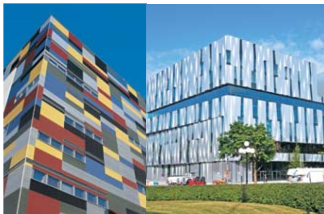
Фасады зданий. Материал PVDF
