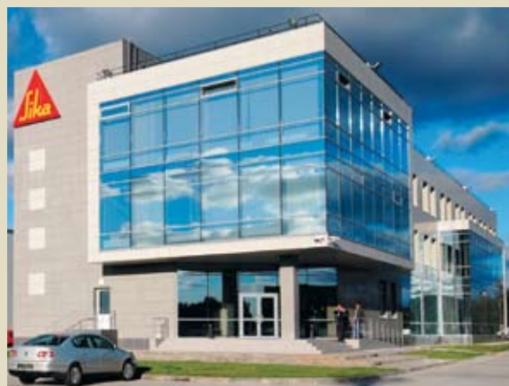
Центральный офис ООО «Зика», г. Лобня, Московская область
