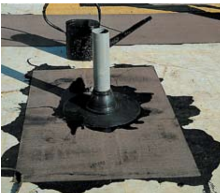
Рис. 5. Установка вентиляционного дефлектора
