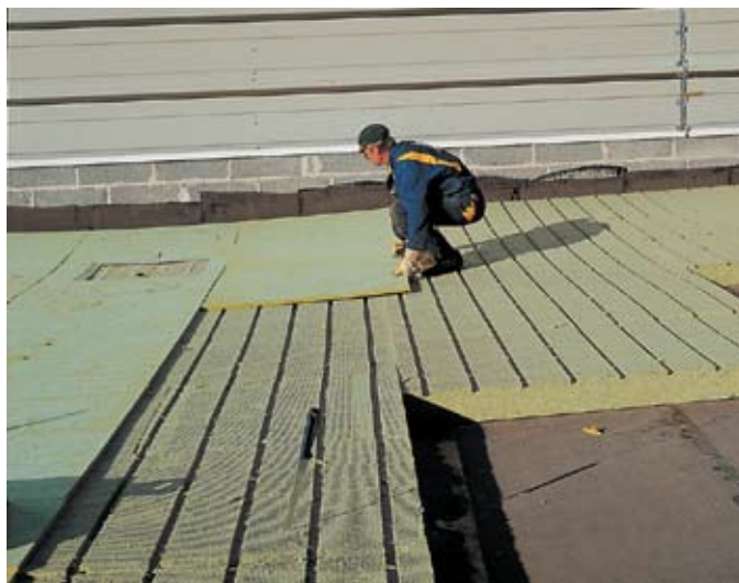
Рис. 4. Укладка теплоизоляционных плит PAROC ROB 80t (верхний слой)
