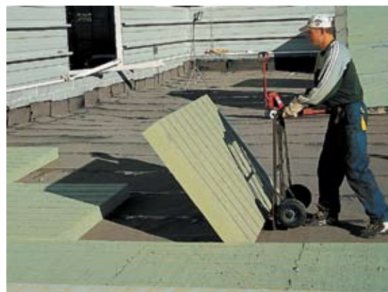
Рис. 2. Укладка теплоизоляционных плит с канавками PAROC ROS 40g
