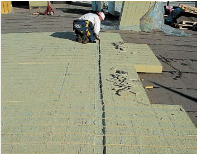
Рис. 3. Соединение канавок сборным коллектором
